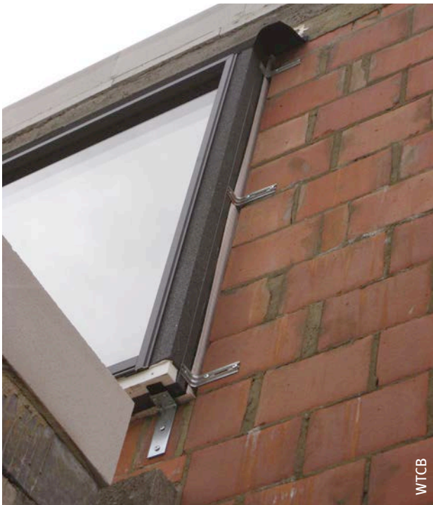
Afb. 89 Plaatsing van het schrijnwerk juist na het optrekken van het binnenspouwblad.
