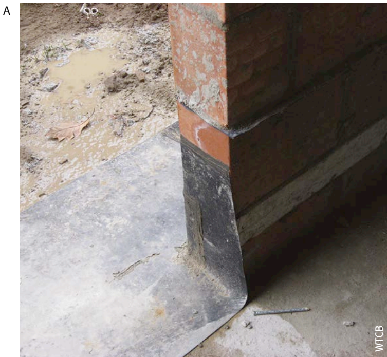
Afb. 88 Muurvoet van het binnenspouwblad.
