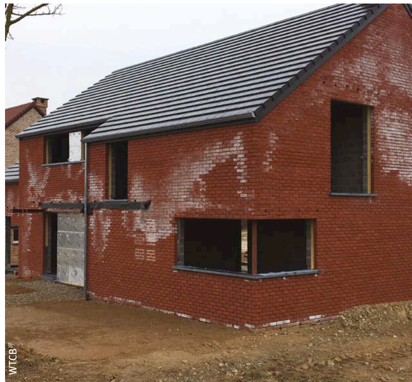
Afb. 61 Verschijning van uitbloeiingen in de lente wanneer de drogingsomstandigheden gunstig zijn.
