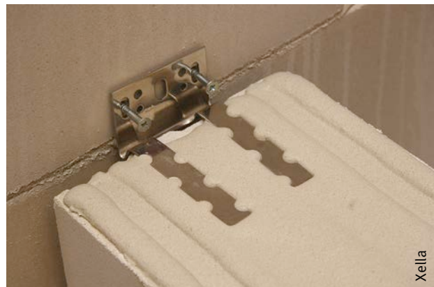
Afb. 82 Voorbeeld van een glijanker (veeranker).
