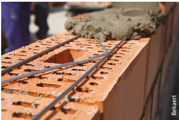
Afb. 66 Lintvoegwapening uit gelaste draden (vakwerktype).
