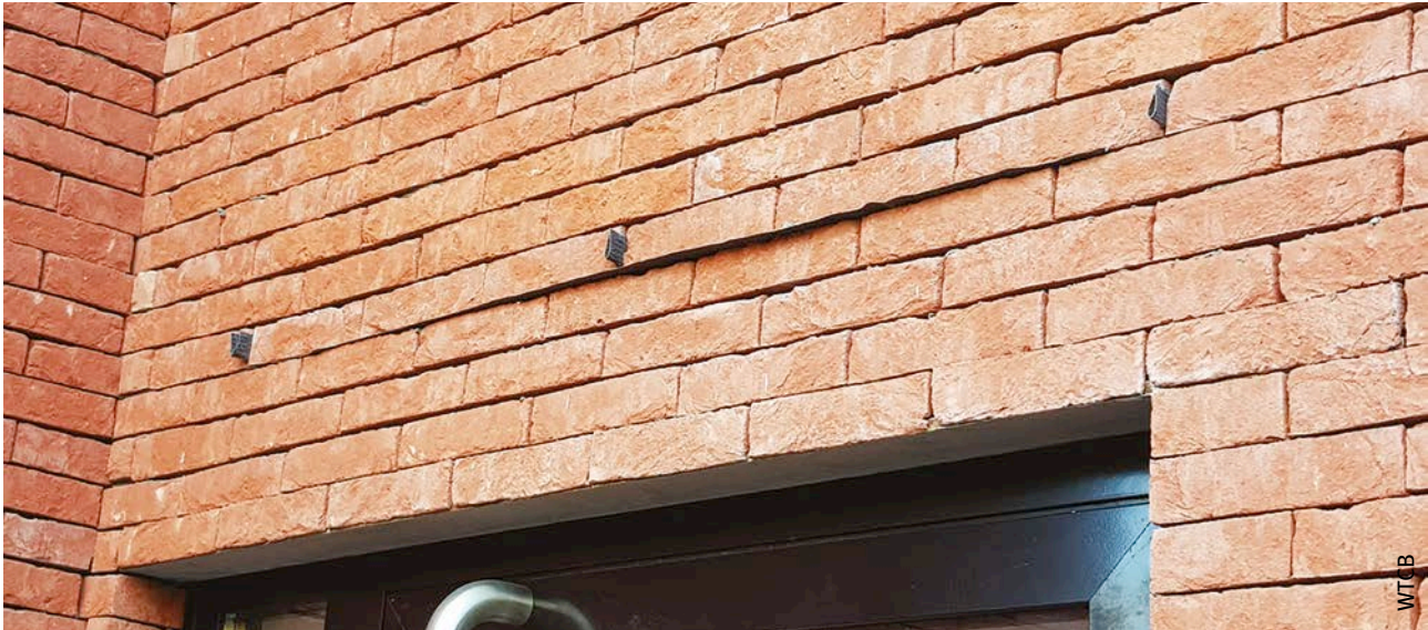
Afb. 95 Open stootvoegen boven het draineringsmembraan.
