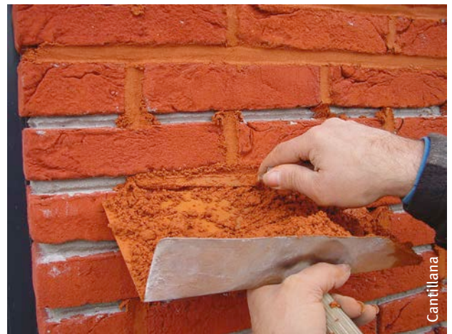
Afb. 113 Navoegen met een gepigmenteerde mortel van een voldoende uitgekraabd metselwerk.
