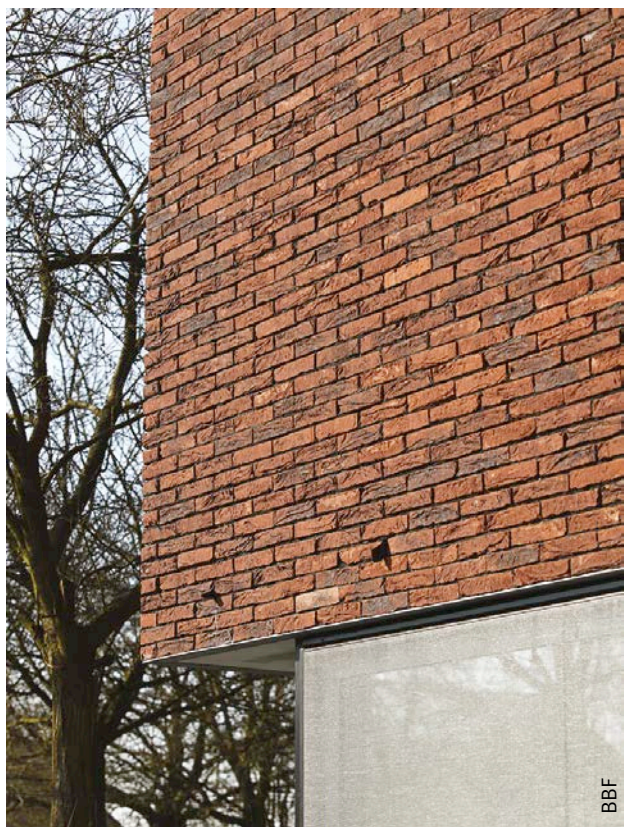
Afb. 1 Gevelmetselwerk uit baksteen, gelijmd met dunne voegen.
