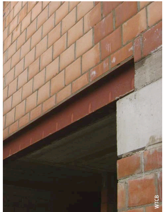
Afb. 69 Geprefabriceerde balk die op een mortellaag en een verdeelbalk aangebracht wordt.
