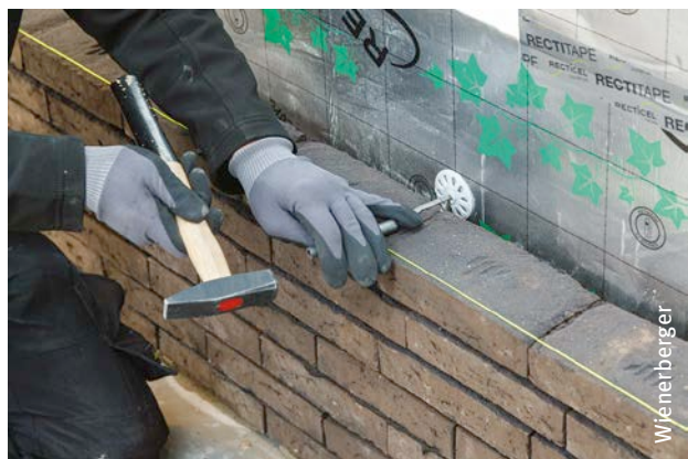
Afb. 68 Mechanische bevestiging van een anker.
