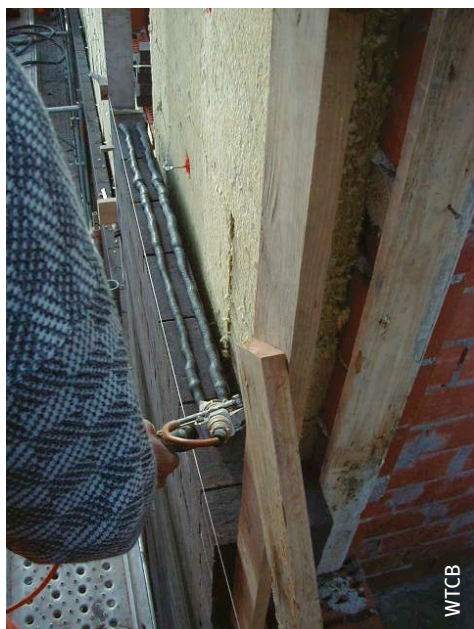
E. Aanbrengen van de mortellijmrillen op de kopse kanten
