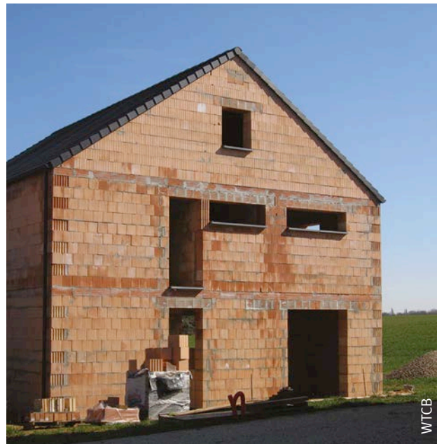
Afb. 11 Dragend metselwerk uit baksteen met dunne voegen (van 0,5 tot 3 mm).
