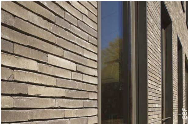
Afb. 46 Gelijmd baksteenmetselwerk met dunne voegen.
