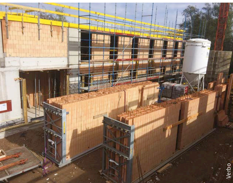
Afb. 29 De geprefabriceerde wanden worden voor hun transport op sledes geplaatst.
