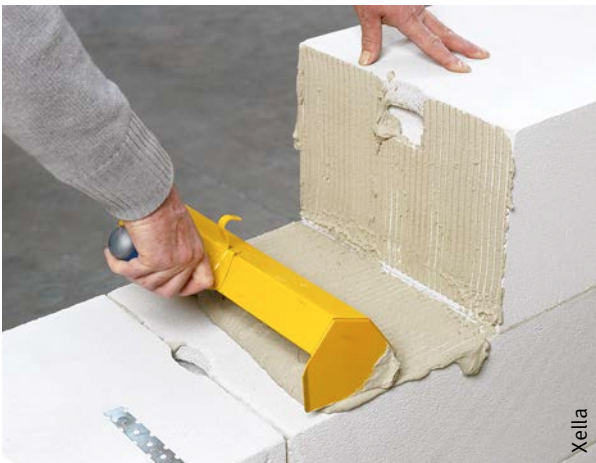
A. Verlijming van dragende blokken uit geautoclaveerd cellenbeton met behulp van een getande spatel (kam)
