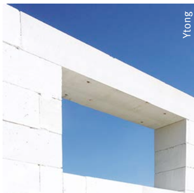
Samengevoegde latei uit geauto-claveerd cellenbeton
