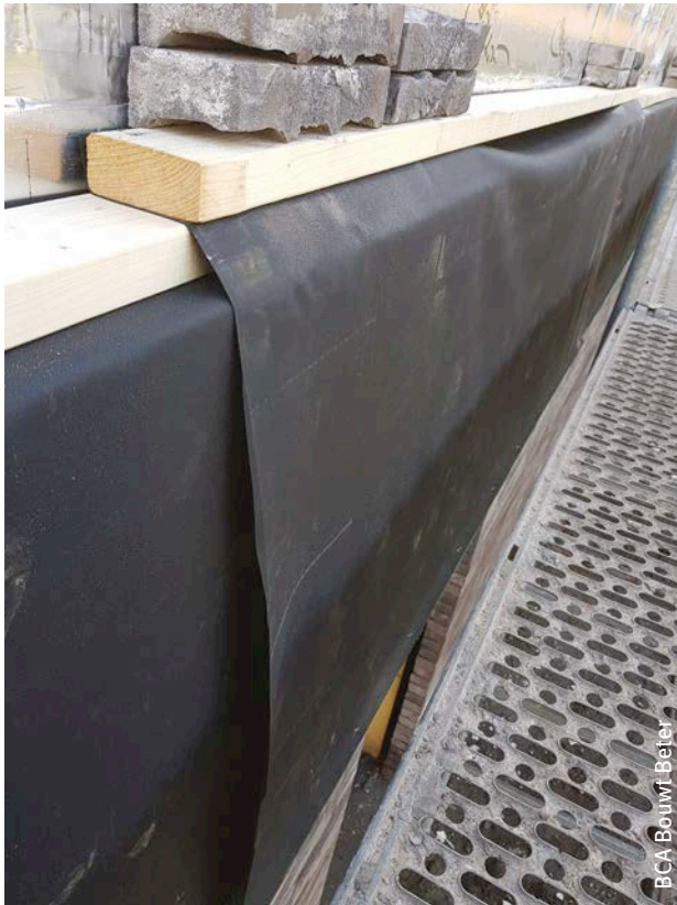
Afb. 62 Voorbeeld van de bescherming van een vers gemetseld buitenspouwblad.
