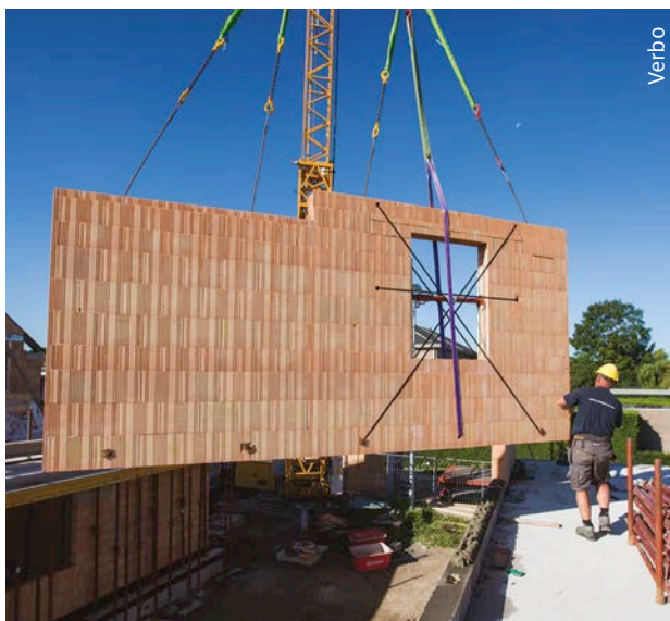
Afb. 55 Plaatsing van geprefabriceerd metselwerk.
