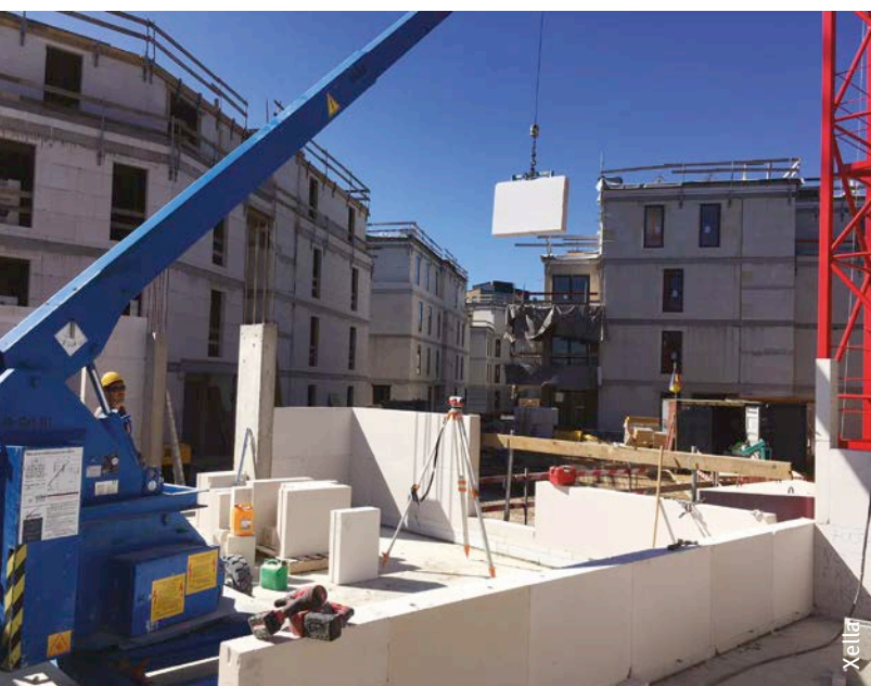
Afb. 50 Plaatsing van zware metselstenen met behulp van een kleine kraan.
