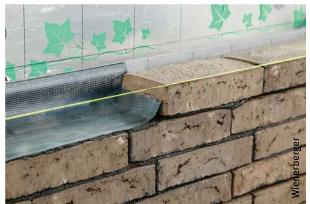
Afb. 94 Opstand van het draineringsmembraan aan één van de uiteinden.
