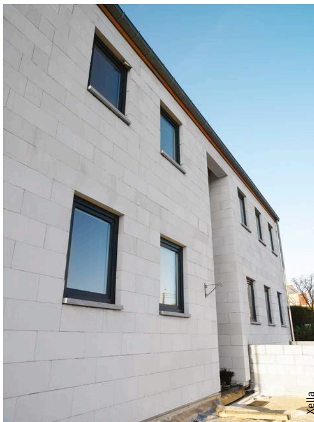
Afb. 2 Dragend metselwerk uit cellenbeton met dunne voegen.
