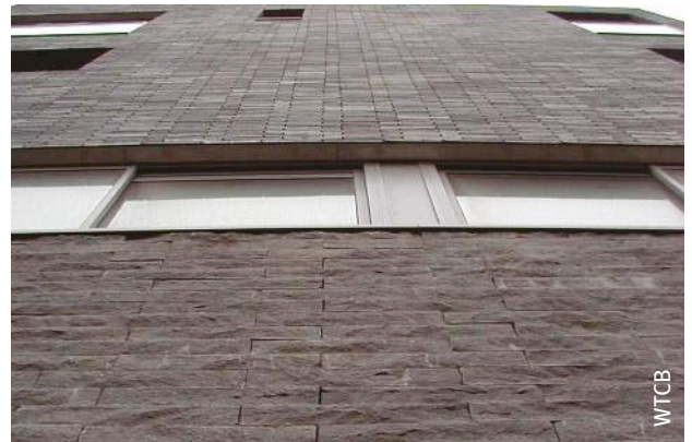
Afb. 47 Gelijmd metselwerk met metselstenen uit natuursteen met dunne voegen.
