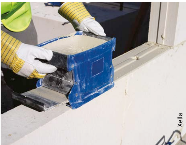
Afb. 52 Verlijmingstechnieken voor dragende blokken.
