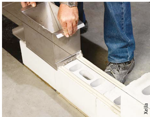
D. Verlijming van dragende blokken uit kalkzandsteen met behulp van een lijmbak – Metselwerk met onderbroken voegen ( shell bedded masonry )
