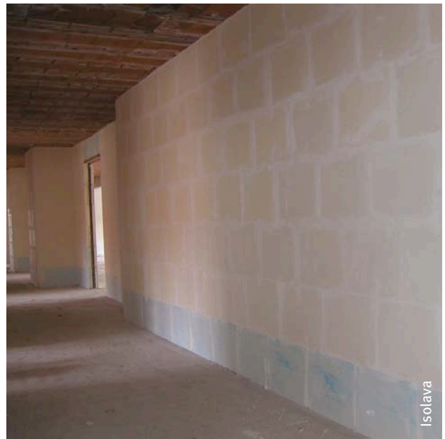
Afb. 59 Niet-dragende binnenwand uit gipsblokken.
