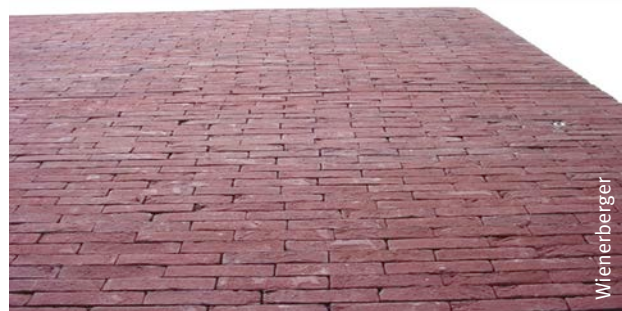
Afb. 39 Gelijmd metselwerk met dunne voegen. Regelmatig verband. Slechte uitlijning van de stootvoegen omwille van een baksteen met minder strenge toleranties.
