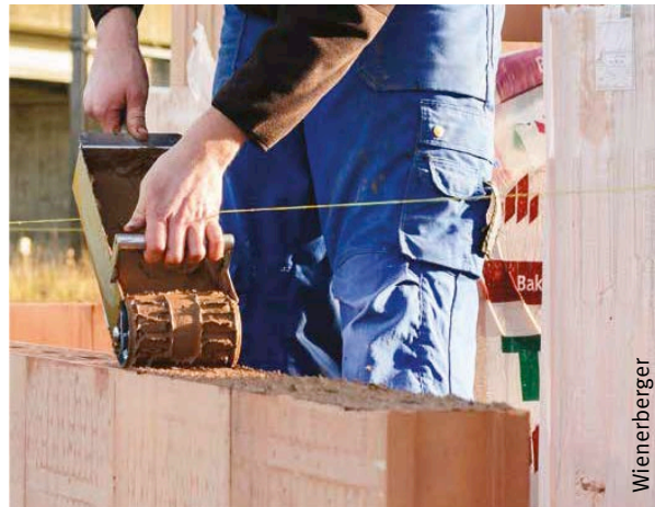
B. Verlijming van snelbouwstenen met behulp van een rolbak
