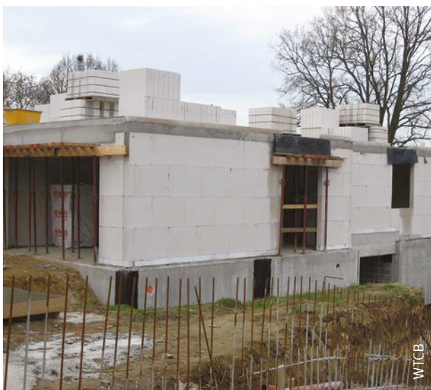
Afb. 38 Metselwerk uit kalkzandsteenblokken met dunne voegen (0,5 - 3 mm).
