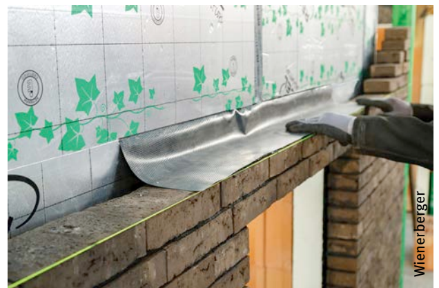
Afb. 93 Draineringsmembraan boven een opening.
