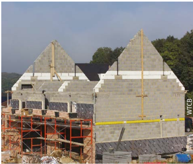
Afb. 12 Traditioneel dragend metselwerk uit betonmetselstenen (voegen van 10 tot 12 mm).
