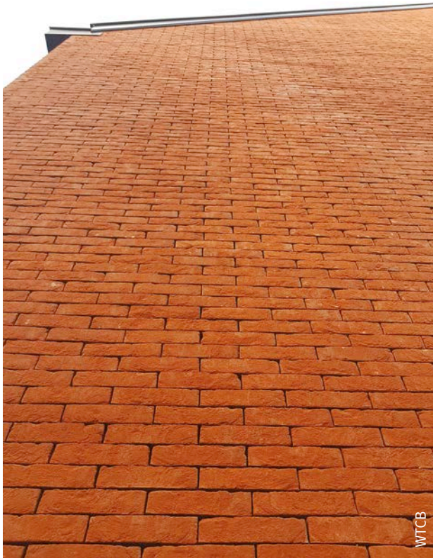
Afb. 40 Gelijmd metselwerk met dunne voegen. Regelmatig verband. Goede uitlijning van de stootvoegen.
